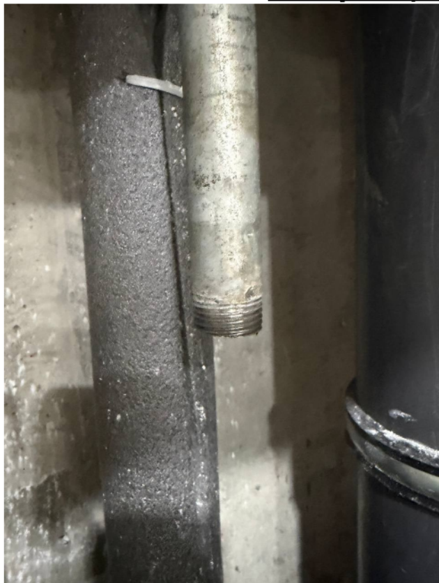
Фото 3. Резьбовая часть отвода ХВС в ходе ремонтно-восстановительных работ.
