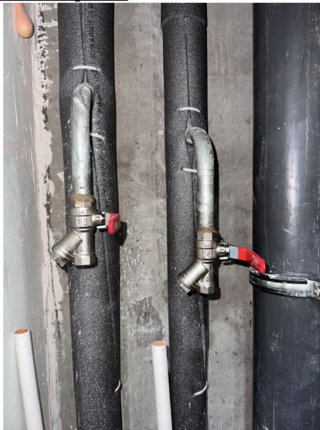
Фото 4. Общий вид вводных узлов после установки запорной арматуры.
